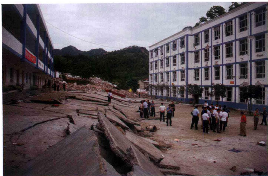
彭州市白鹿镇中学的两栋教学楼分别位于地震断裂带的两侧，地震时断裂错动达2.1米。陈立新 摄
