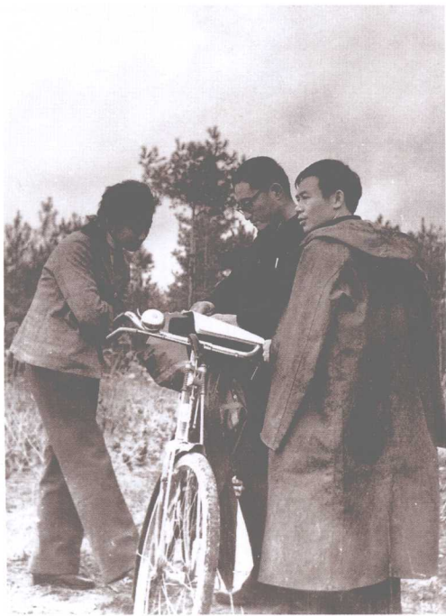
图5 1983年赵大川和技术人员在喷灌工程现场
