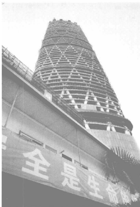
图3 432m高的广州西塔目前已建造超过350m
