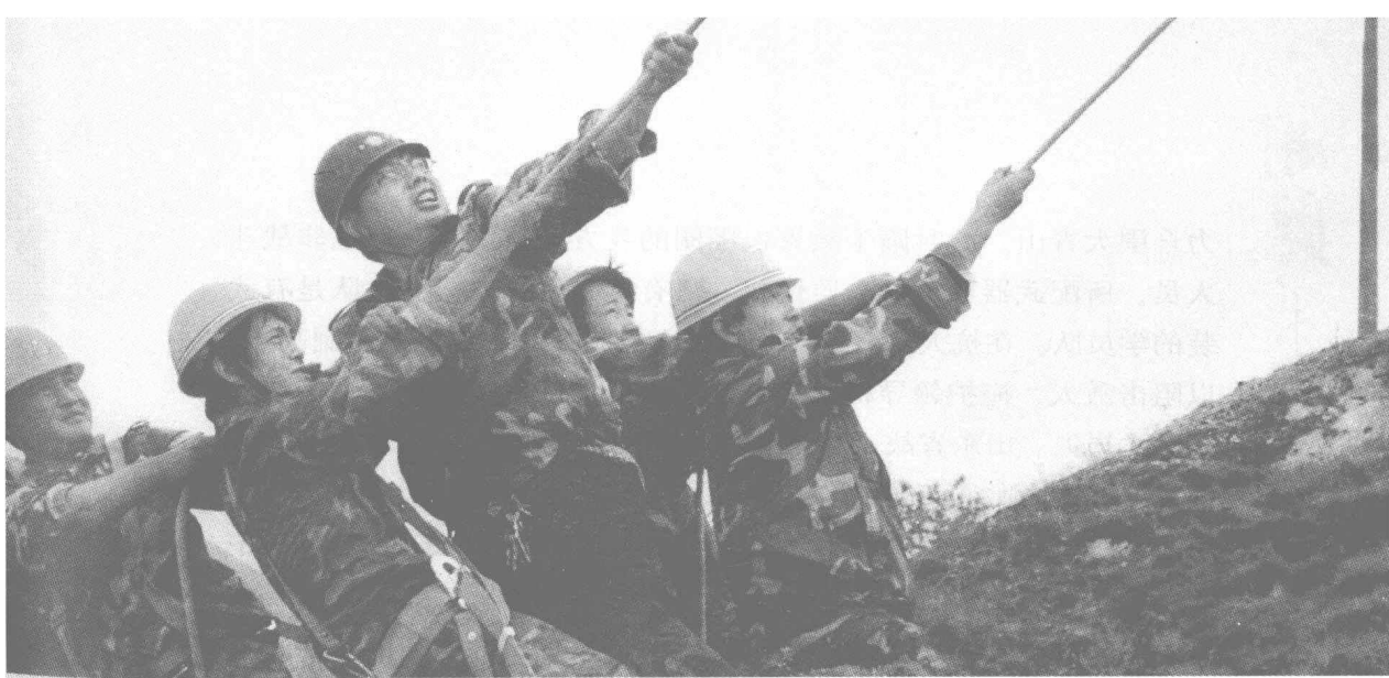
▲ “户户通电”施工现场
