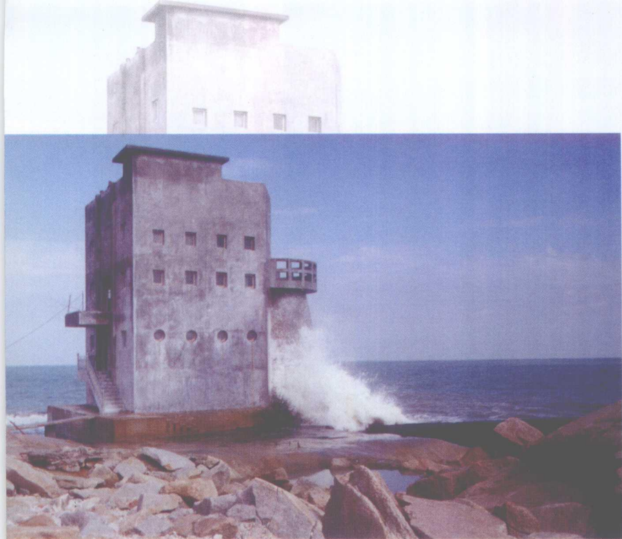
玉树州县结险乡小型风光互补电站 100kW 岸式振荡水柱波能电站
