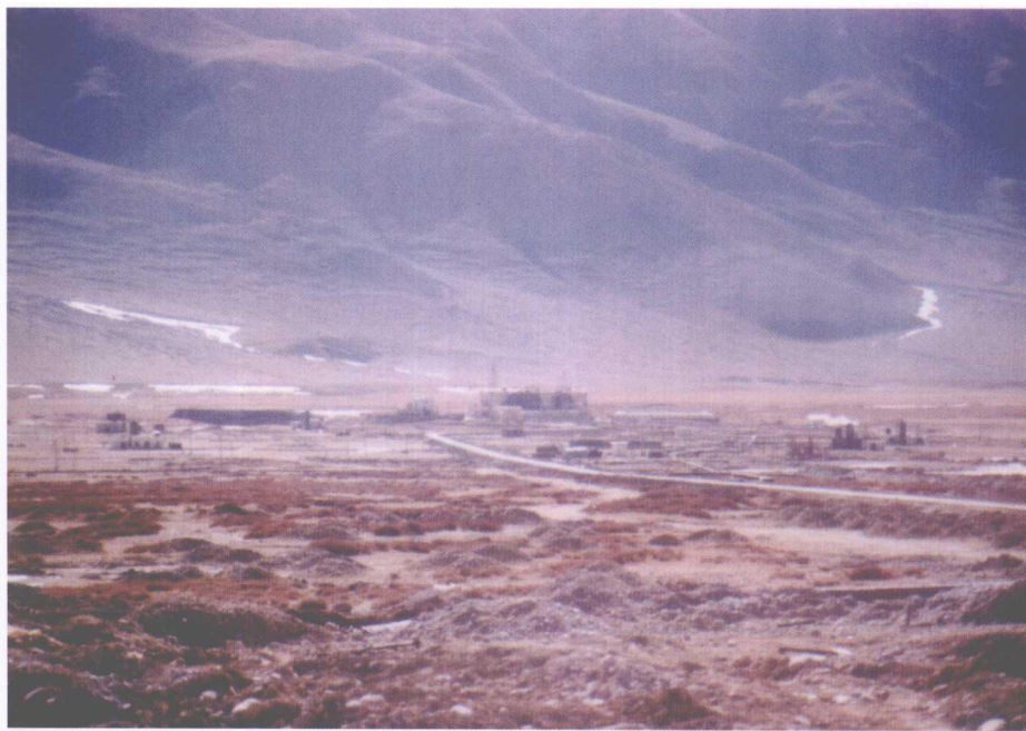
羊八井地热电站全景
