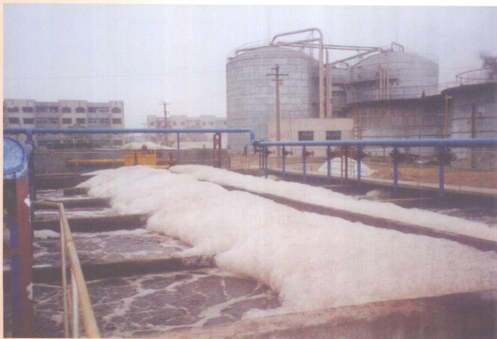
▼ 泗水酒精厂厌氧——好氧工艺处理薯干酒精废液工程
