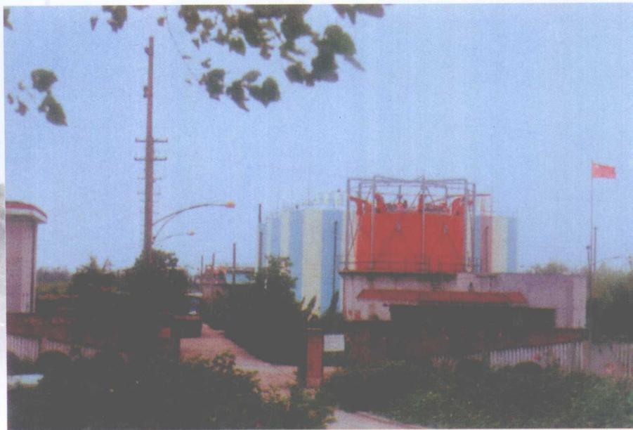
▲ 奉贤星火农场牛、鸡粪处理沼气工程
