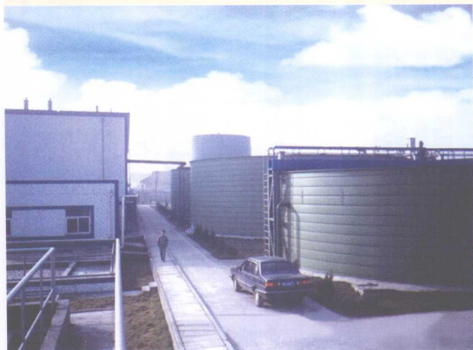
▲ 灯塔 20 万头养猪场沼气工程
