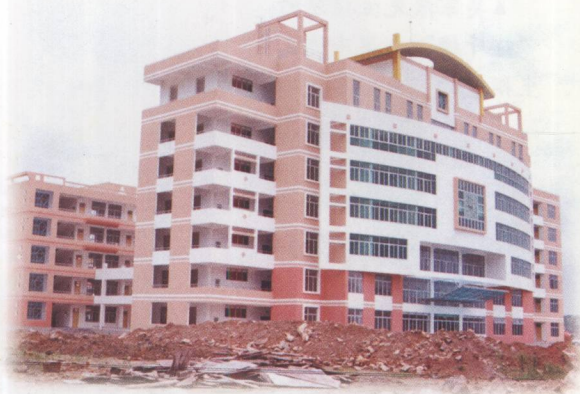
►施工中的 “黄如论中学”。
