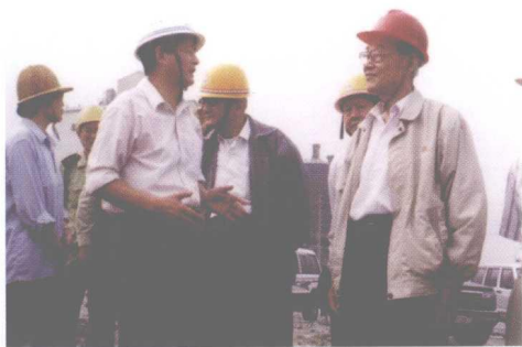
1998 年李鹏鼎（右一）在三峡工地查看永久船闸施工现场
