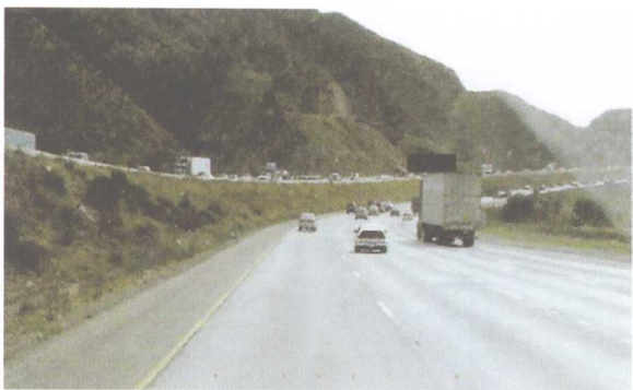
图2 国外高速公路为顺应地形上下线不在一个平面上
