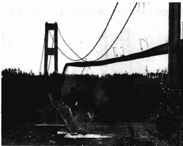
图 1-4 倒塌的老塔科马大桥
