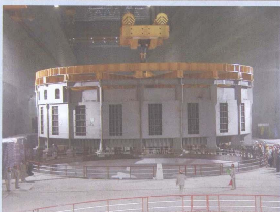
大型发电机定子整体吊装技术
