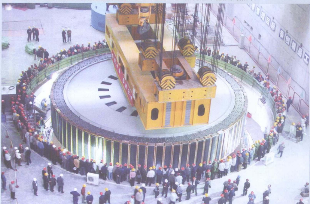
大型发电机转子安装技术
