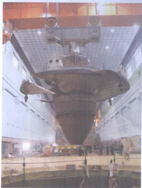
葛洲坝水电站需修复改造的水轮机转轮和顶盖
