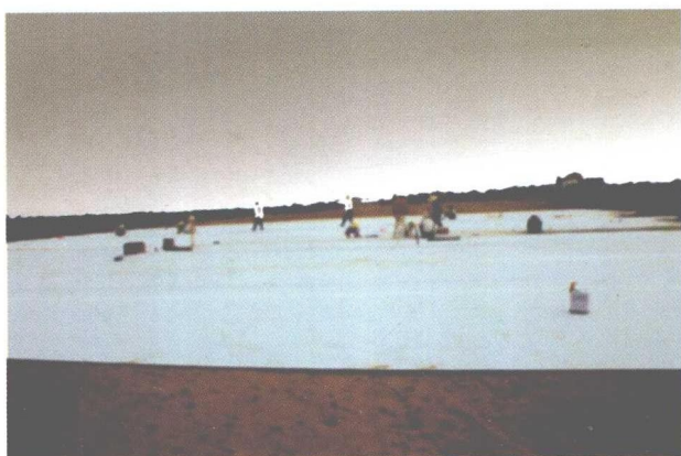
铺设土工布路段
