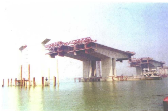
海隆大桥悬臂施工箱梁
