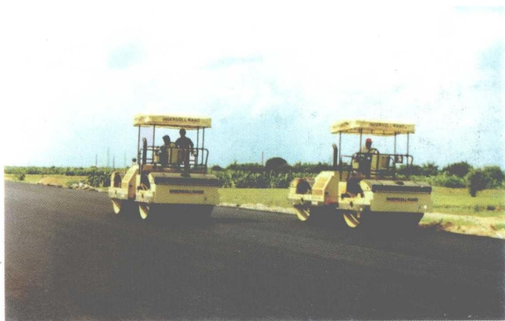
英格索兰压路机碾压沥青混凝土路面
