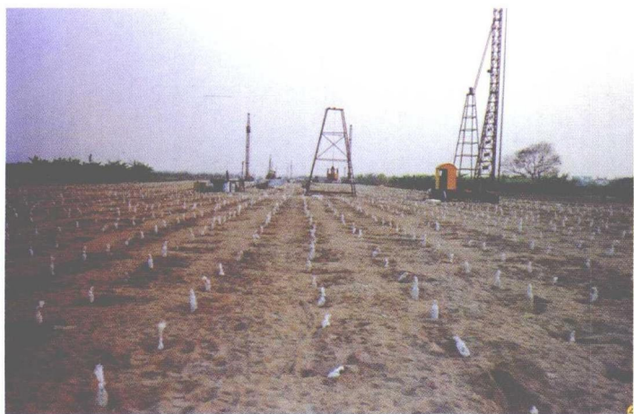
袋装砂井施工现场
