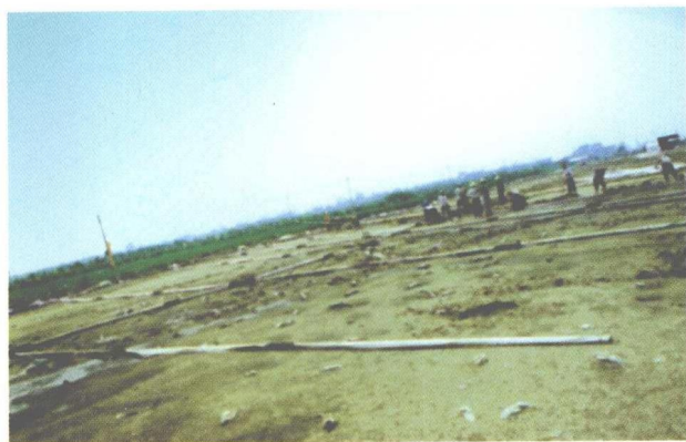
真空预压软基施工现场
