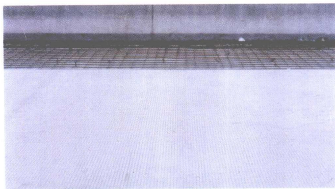
正在施工的钢纤维混凝土桥面
