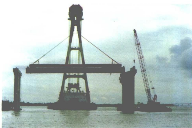
横沥大桥 50m T 型梁吊装
