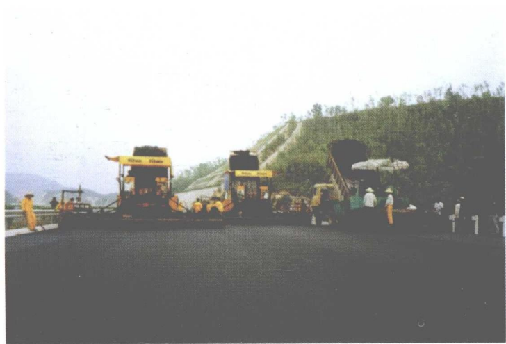
精心施工中的广珠段路面工程
