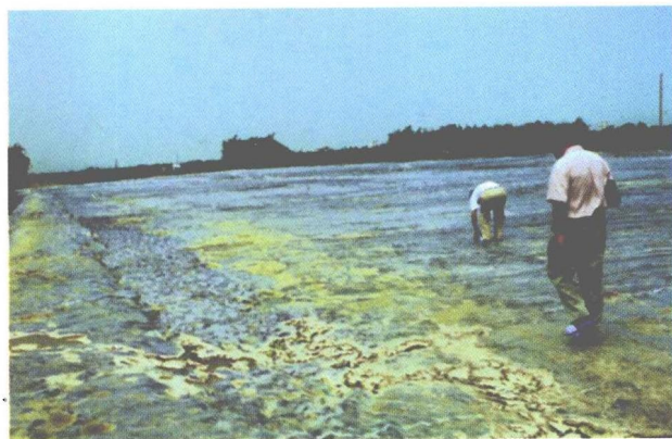
真空预压试验段铺设真空膜后
