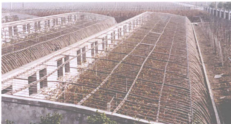
未覆盖塑料薄膜的日光节能型塑料温室
