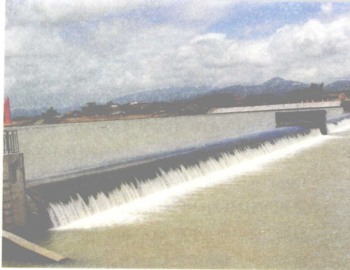
诏安县的水利工程
