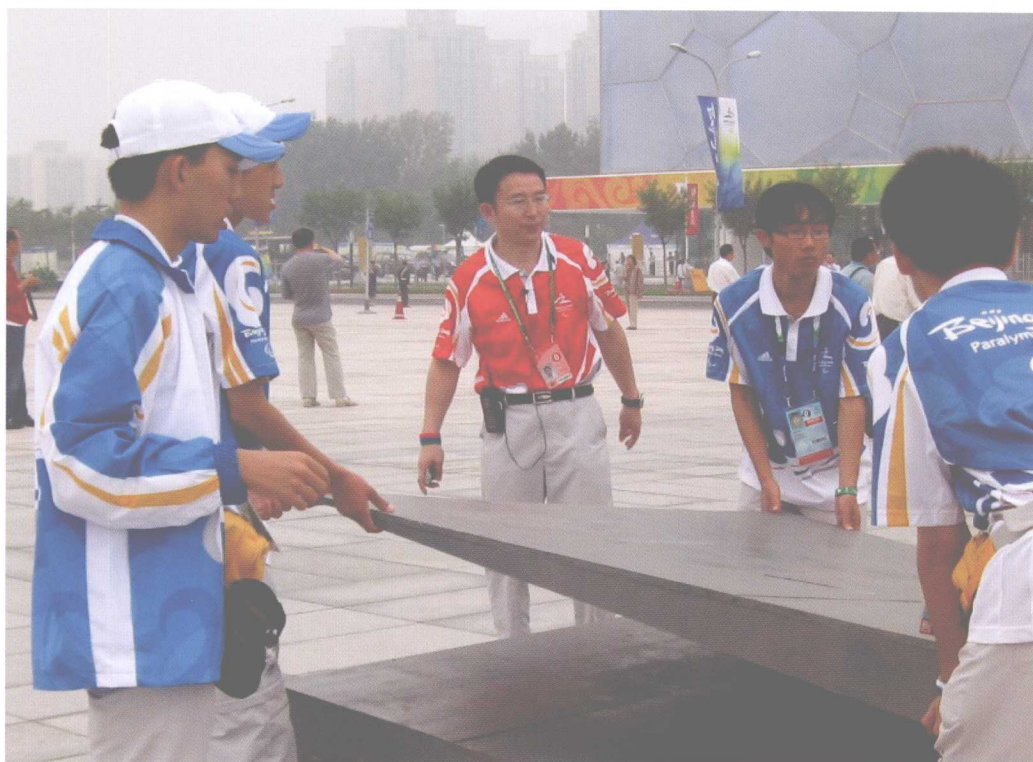
图 20 北京奥组委交通部副部长宋甘澍（中）指导志愿者安装残奥会交通服务设施
