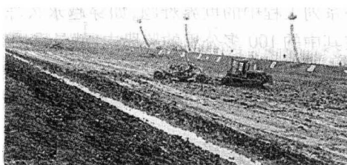
图 1.13 南水北调工程
