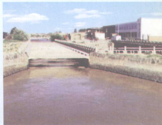
秦渠跨山水沟的渡槽
