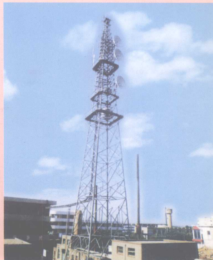
市区电视接收塔
