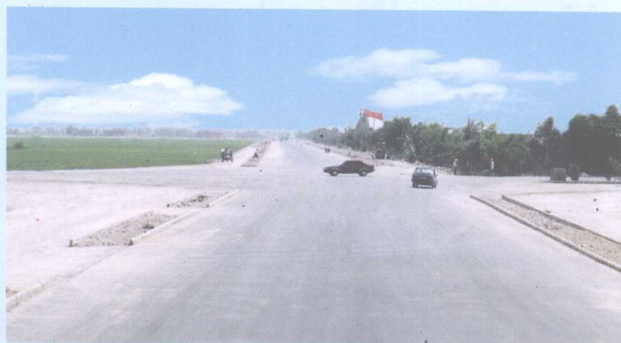
构筑城市新框架,宽敞的环城路建成
