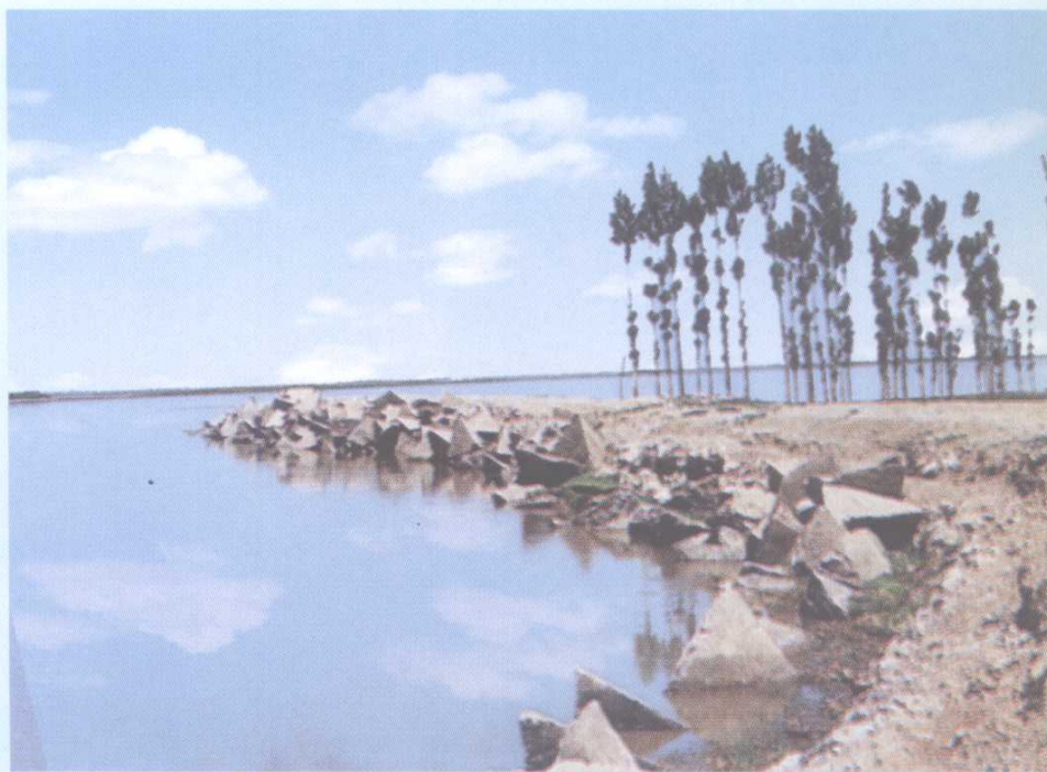
黄河水泥混凝土四面体护岸
