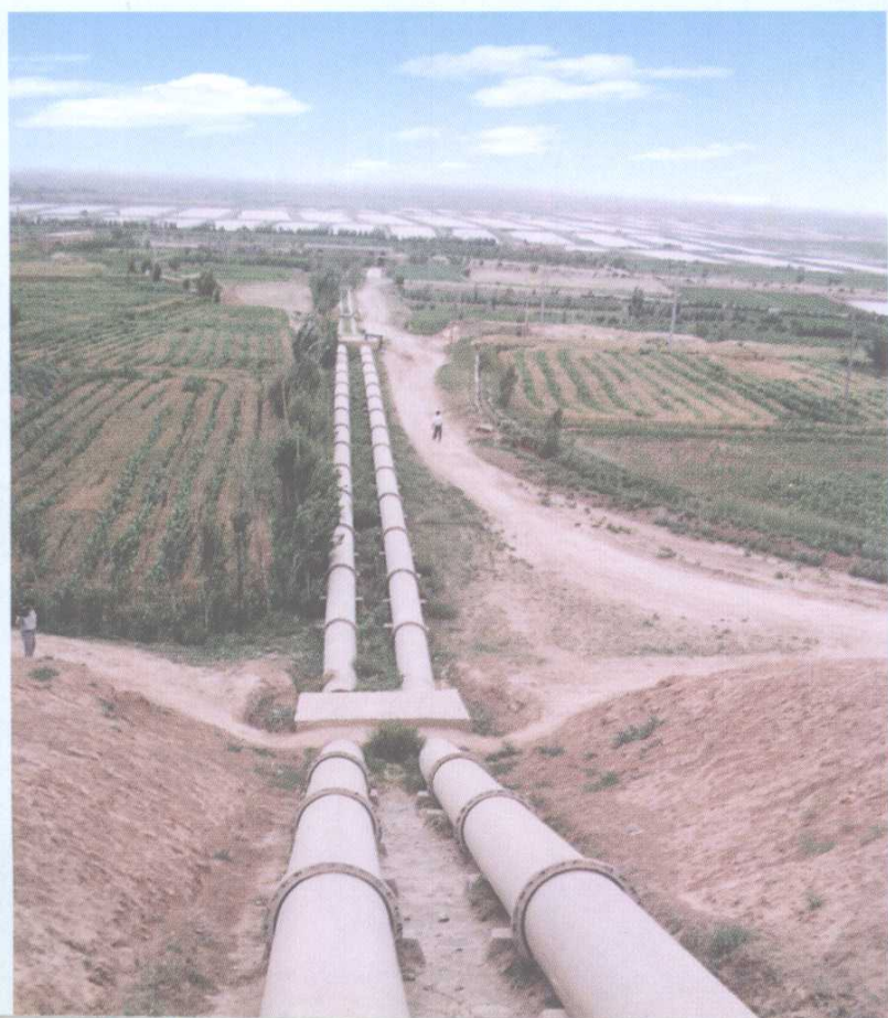
开发狼皮子梁荒漠的引水灌溉工程
