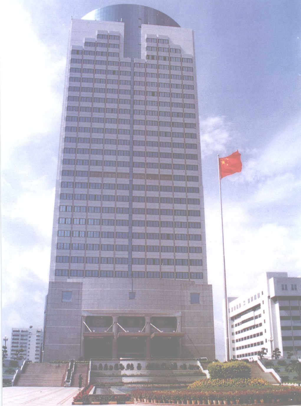
● 中共福田区区委、区政府办公大楼
