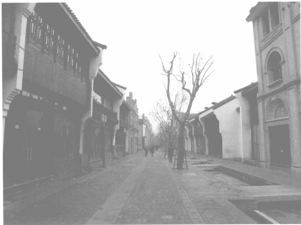
中山中路两旁的老建筑是老街重新崛起的重要文化资源。
