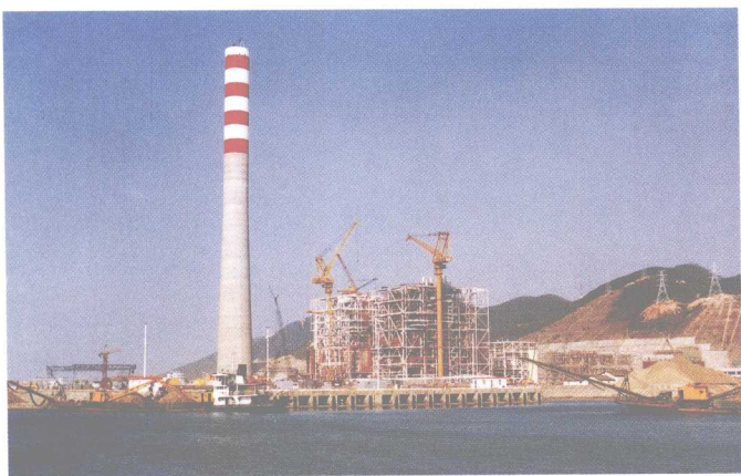
1998年建设中的珠海电厂
