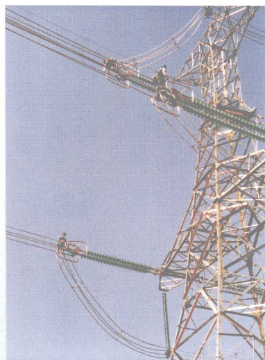
2000 年 12 月, 500 千伏 曲北线进行竣工验收
