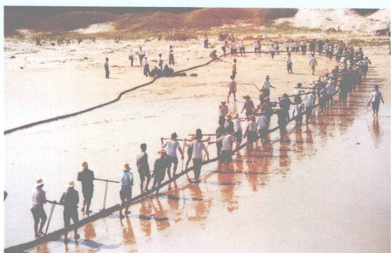
1995 年, 南澳岛 110 千伏海底电缆在施工
