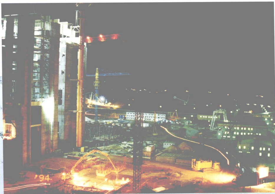
1994年繁忙建设中的沙角C电厂夜景
