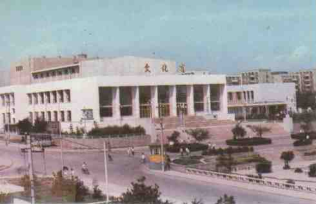
← 该公司于1979年竣工的辽化文化宫，是辽宁省第一个质量样板工程。
