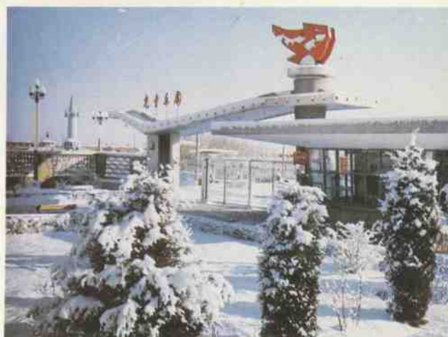
↓ 完成主体，正在装修的鞍钢文化体育中心工程，将是朝阳二建的又一“杰作”。
