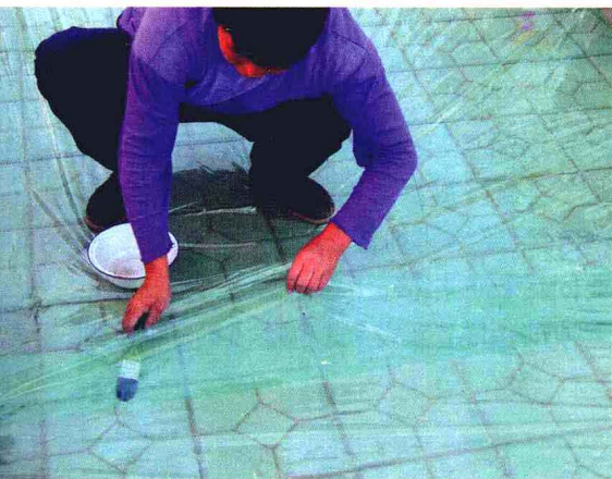
图 1-16 用专用薄膜粘合剂将 2 块薄膜连接起来
