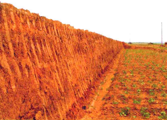
图 1-9 用挖掘机切削以后的温室后墙内侧状况
