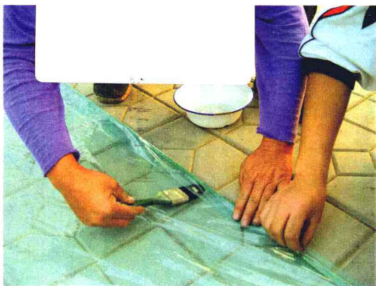
图 1-15 在薄膜边缘包埋尼龙绳
