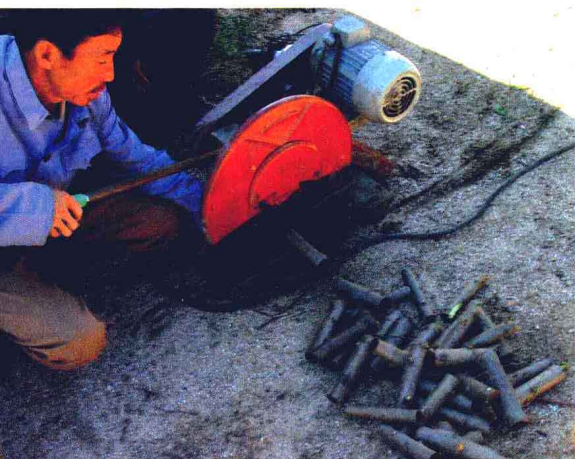
图 1-13 用割机切割小吊柱
