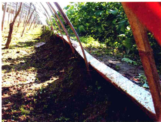
图1-14 温室前沿埋设的起隔热作用的聚苯乙烯泡沫塑料板
