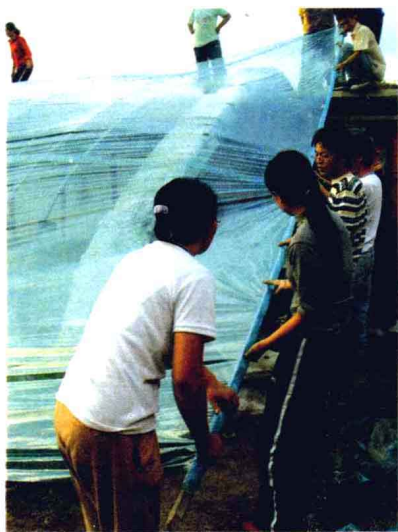
图 1-17 在薄膜两端卷竹片，拉紧后将竹片钉在温室侧墙上
