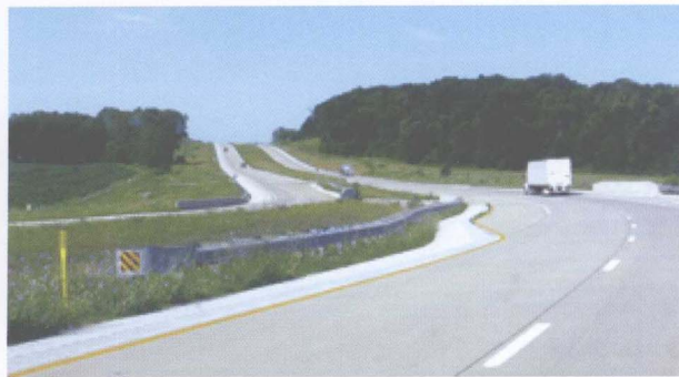
图 1-2 美国某支线道路
