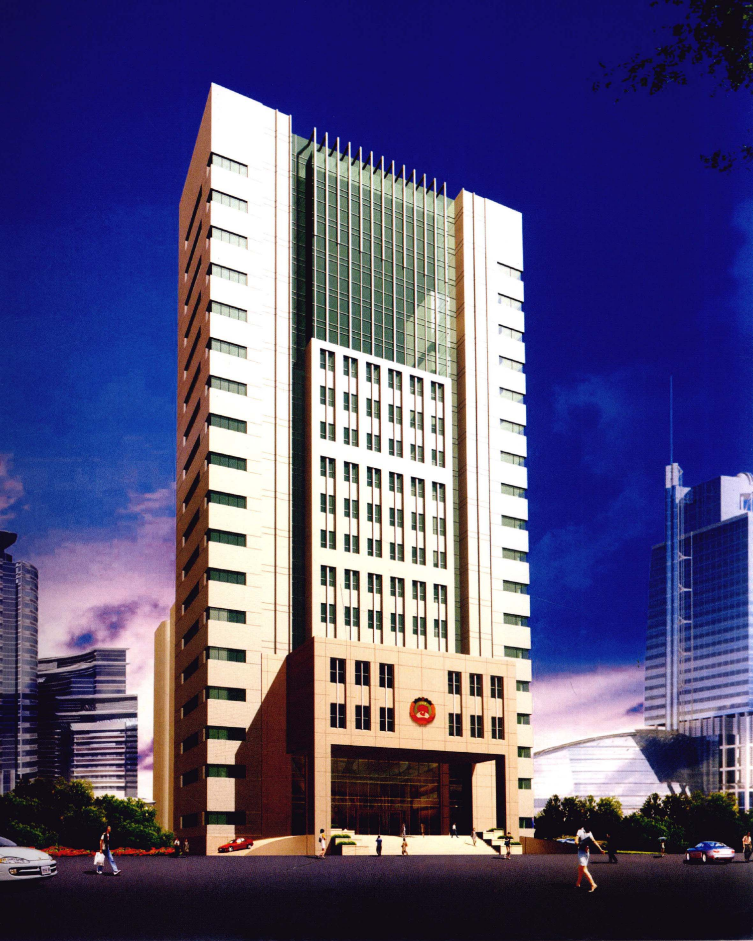
左:建筑竣工后外观实景 右:建筑外观设计效果图
