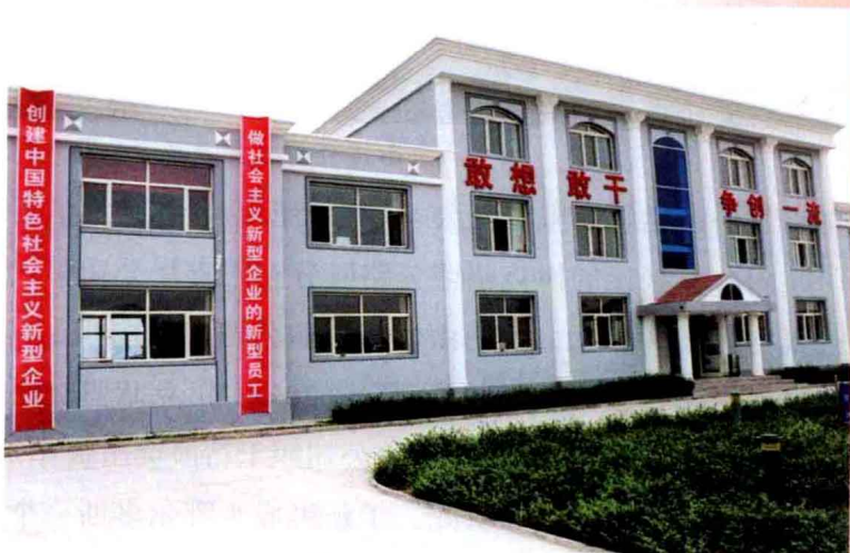
●东信公司办公楼
