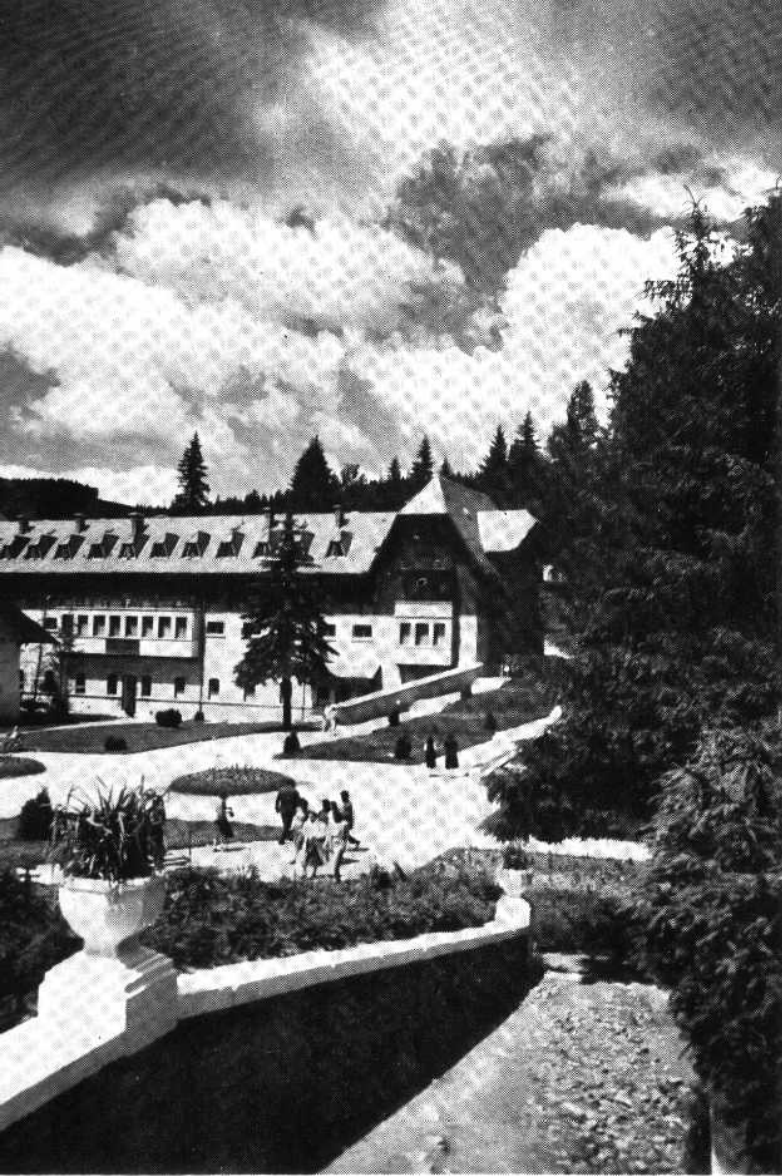
鮑賽克休養地的衛生部中心休養所
