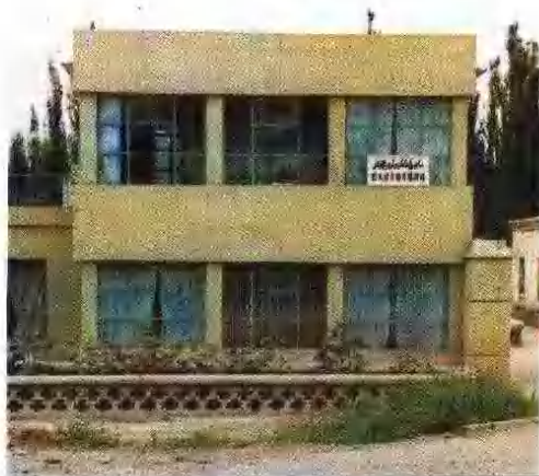
西大桥交通量 观测站
