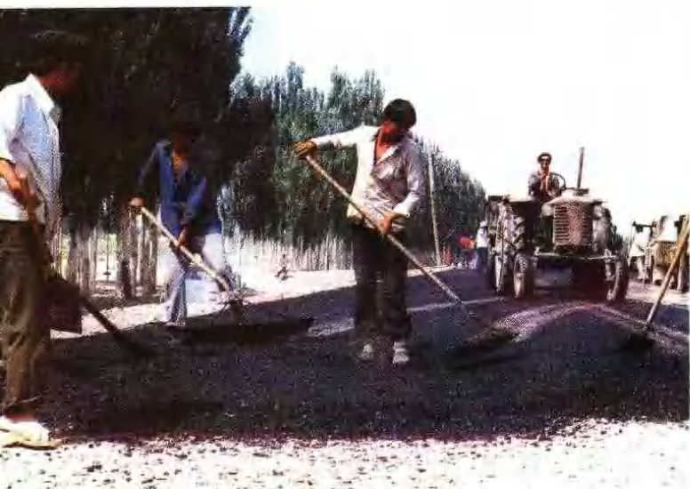
铺筑沥青路面
