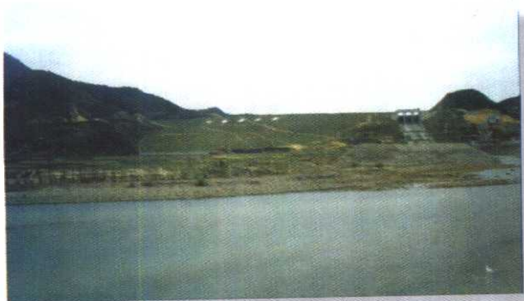
△ 全省最高的粘土心墙土石混合坝——六都寨水库大坝
