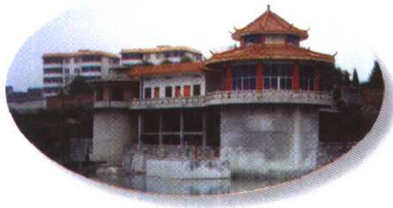
◁ 县城新建的日产3万吨供水工程泵房
