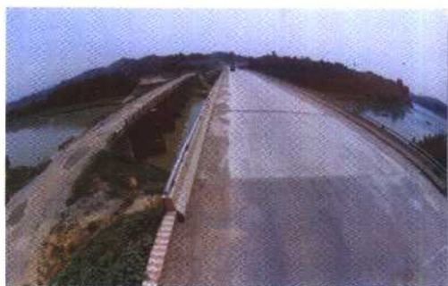
▽ 1998年6月竣工的铜盆江大桥(左为旧桥)
