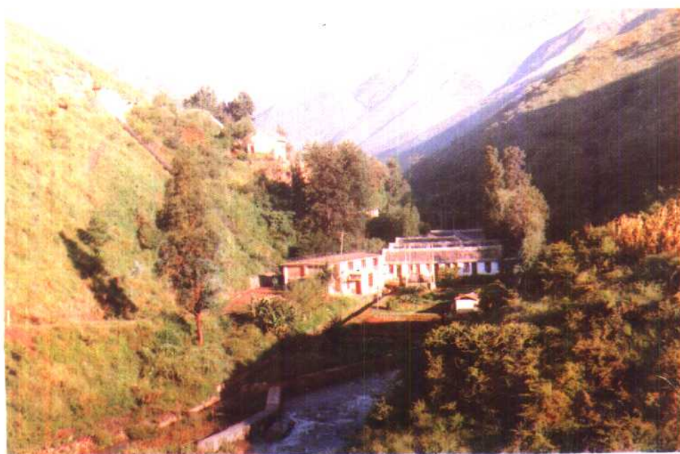
北衙铅矿小水电站
