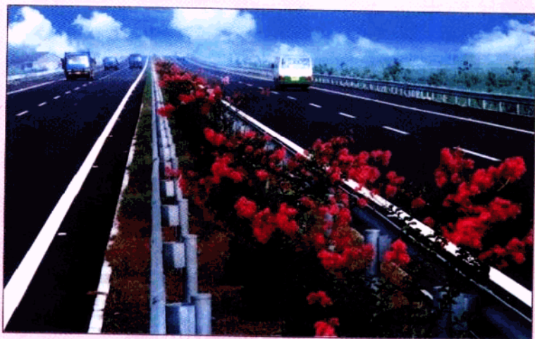
宁通高速公路
