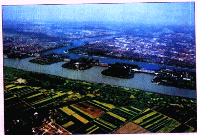
远东最大的水利枢纽工程——江都抽水机站
