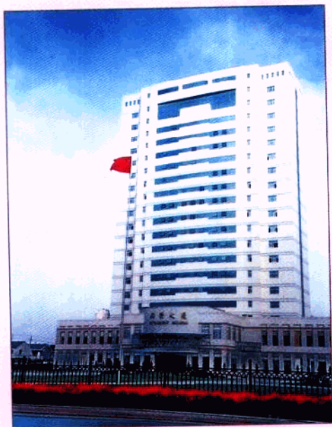
扬州经济开发区管委会 新址——开发大厦
