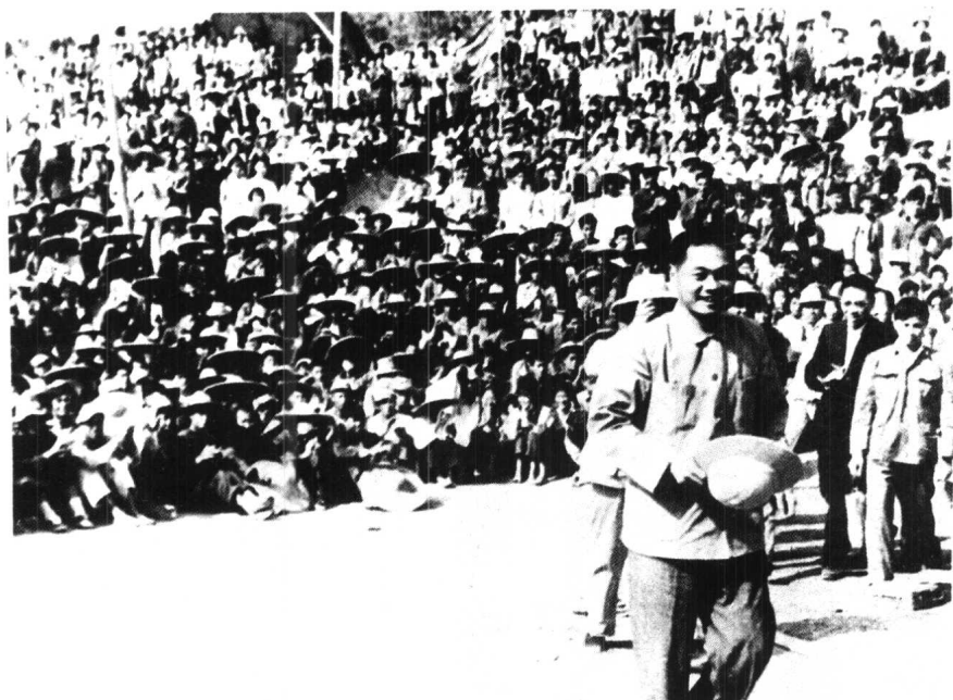
一九六四年十二月，在东江——深圳供水工程 工地慰问各地区民工。
