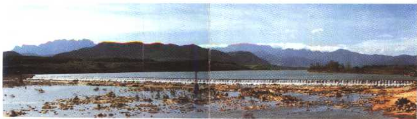
东方电站的拦河坝
