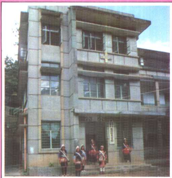
△基诺族乡卫生院门诊楼 (丁志凡 摄)
