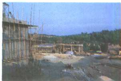
建設中的靖海鎮大型自來水工程
