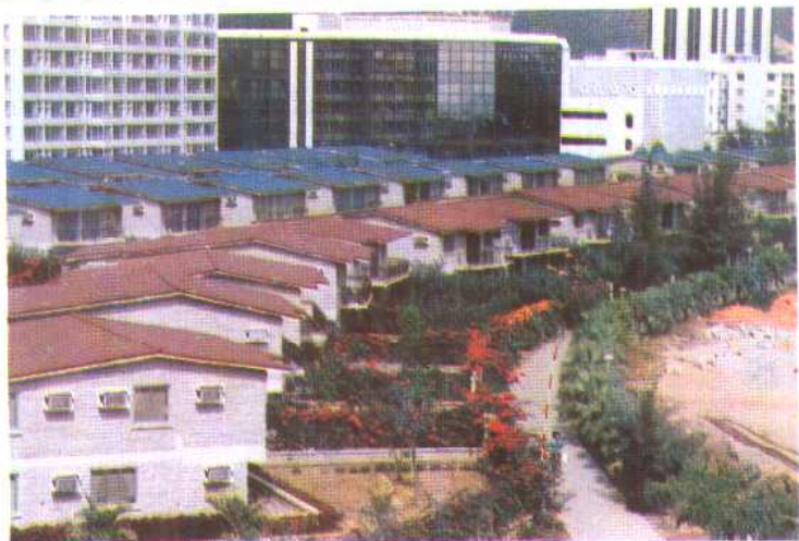
深圳市蛇口工业区专为外商在深圳海滨建造的碧涛苑别墅。
