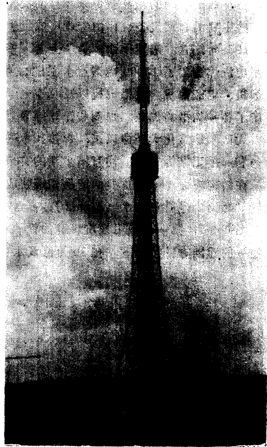
图0-4 209米全焊接结构电视塔
