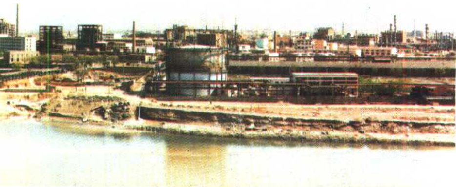
西固工业区一角
