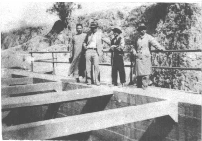
(22) 1935年5月，杨虎城陪同国民政府立法院院长孙科视察洛惠渠工程屈里汽车路渡桥工地。
