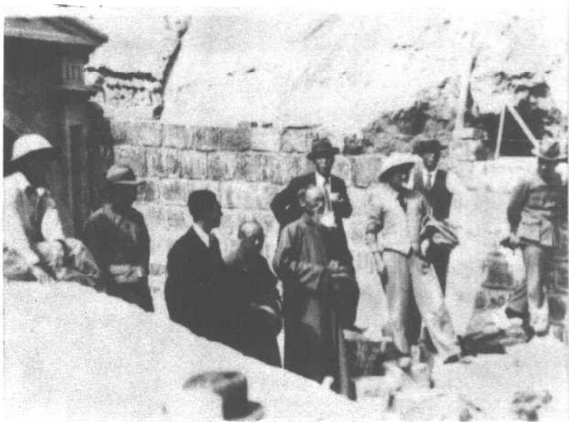
(23) 1935年秋，杨虎城视察洛惠渠工程，在第一号隧洞南口摄。
