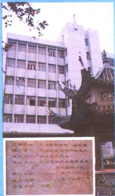
图为大冶市基力建筑工程有限公司自行设计建造的优良工程——大冶市福利院综合楼。公司经理：柯有家；地址：大冶城关；电话：(0714) 713618
