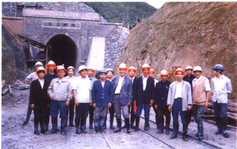
1991 年政协常委视察昆玉铁路玉溪段施工建设情况
