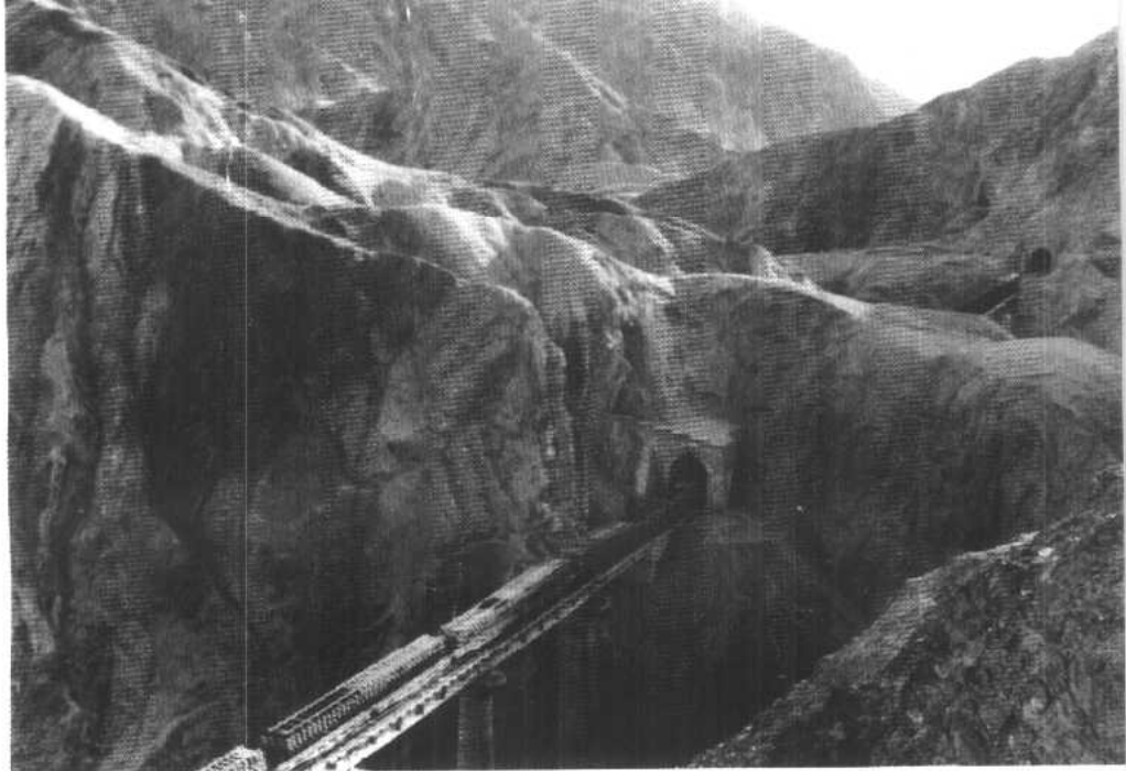
青藏铁路上满载建设物资的列车通过关角隧道
