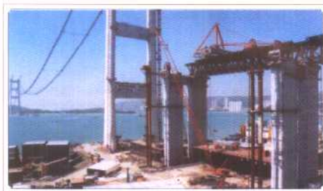
北大嶼山高速公路工程：这条公路连接青马大桥和新机场
