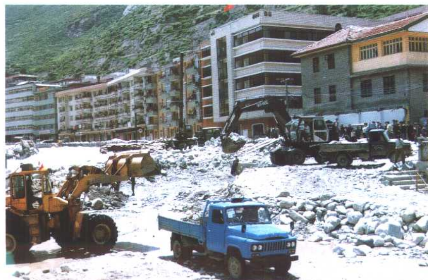
洪災后緊張進行的河道疏浚工程。
