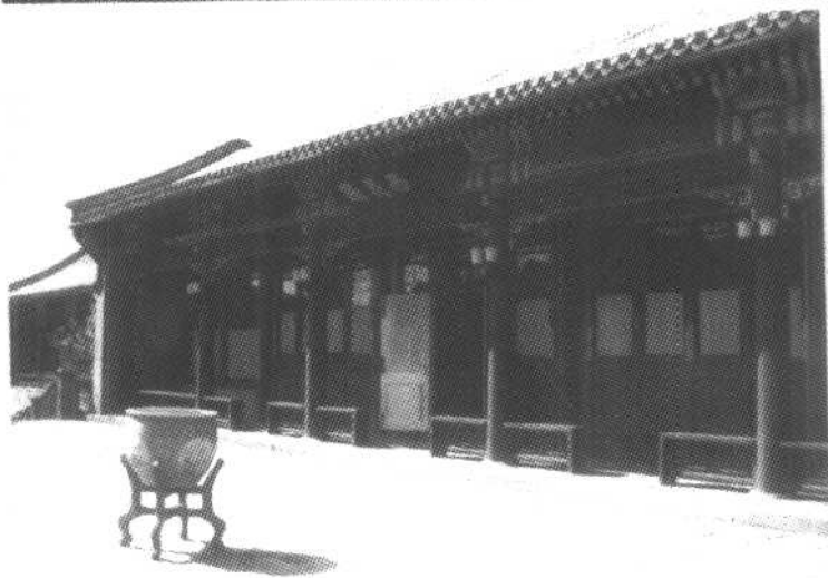
西花厅是周恩来总理制订和组织实施党和国家重大决策的办公场所。图为西花厅外景。
