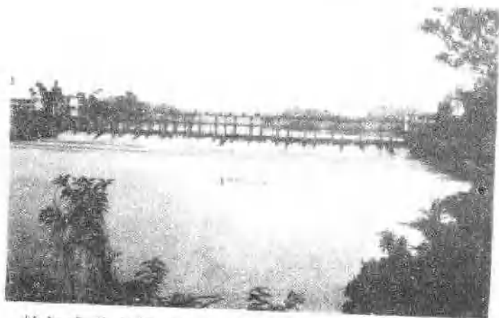
钦江青年水闸,除灌溉农田外,还向城区供水供电。
