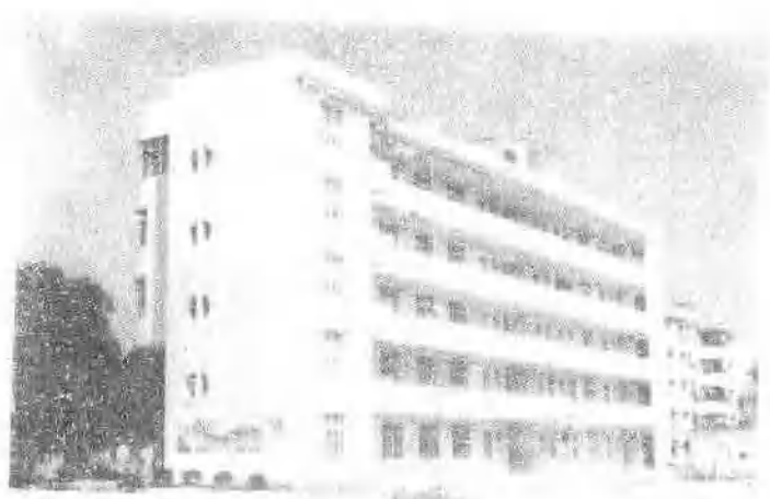
钦州市第四小学教学楼
