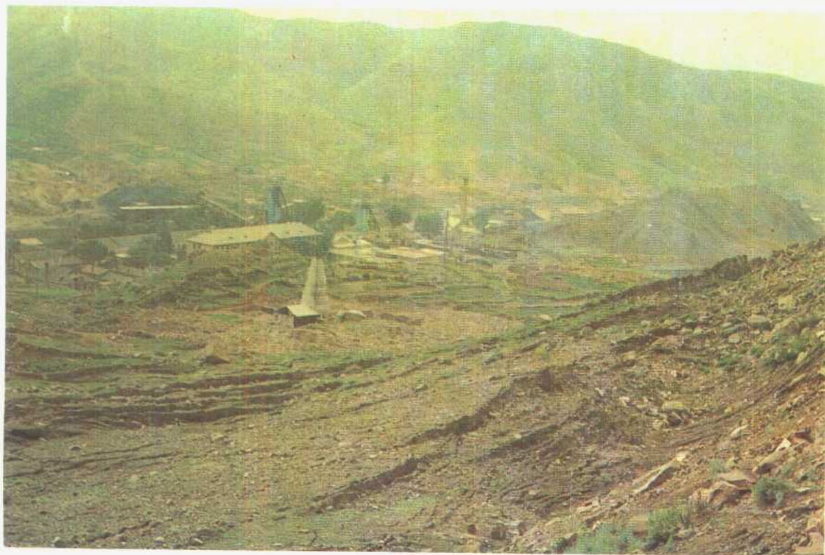
7. 白灰厂滑坡全景
