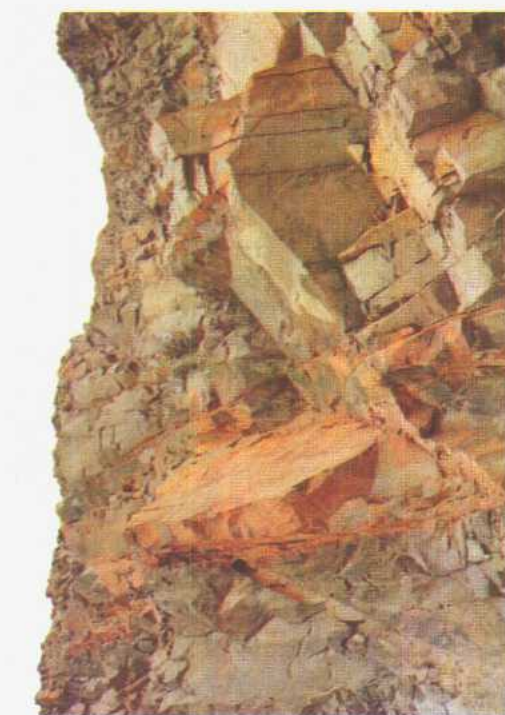
1. 块状结构边坡
