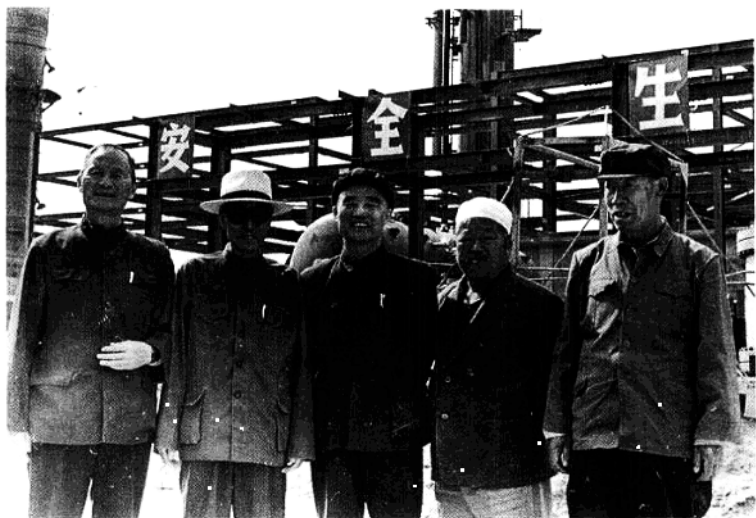
自左至右：自治区政协副主席张源、雷启霖、陈静波、洪清国、杨正喜视察宁夏化肥厂建筑工地。
