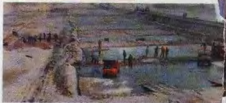
伊敏煤电公司电厂(一期工程)50万千瓦机组土建工程动工。
