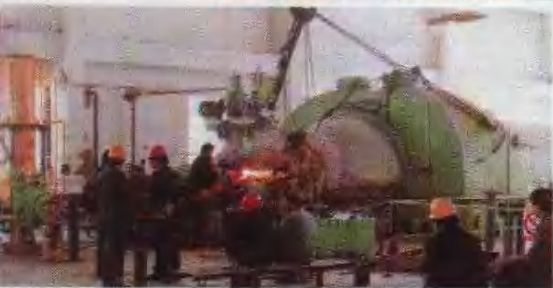
汇流河发电厂扩建一期工程5万千瓦机组安装试车。
