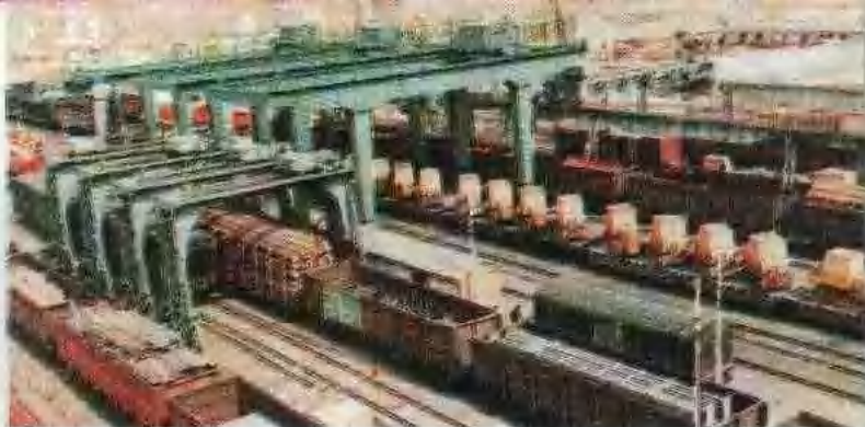
满洲里铁路换装场改建工程竣工投入使用。
