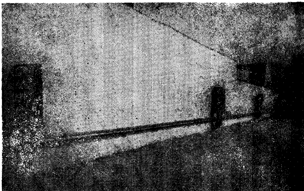
图4 露天预制场上的无压蒸汽养护室
