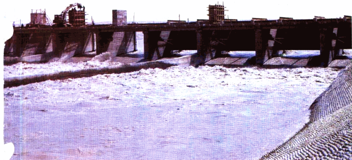
建设中的叶尔羌河喀群拦河枢纽
