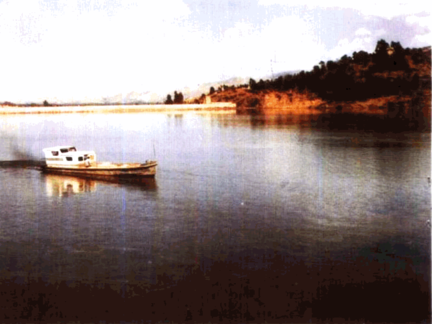
▲ 洋派水库 1954年建成的洋派水库，改善了姚安县10多万亩农田的灌溉条件。
