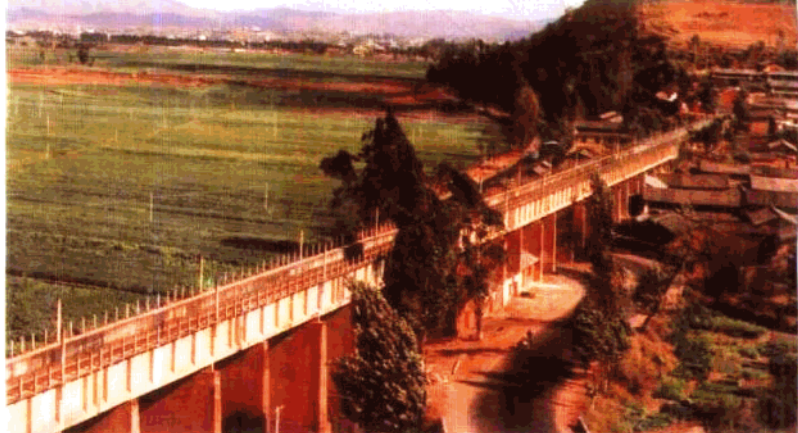
▲ 楚雄渡槽 这是位于楚雄市区西北2公里处 的引龙川江水灌溉楚 雄坝区农田的大渡槽
